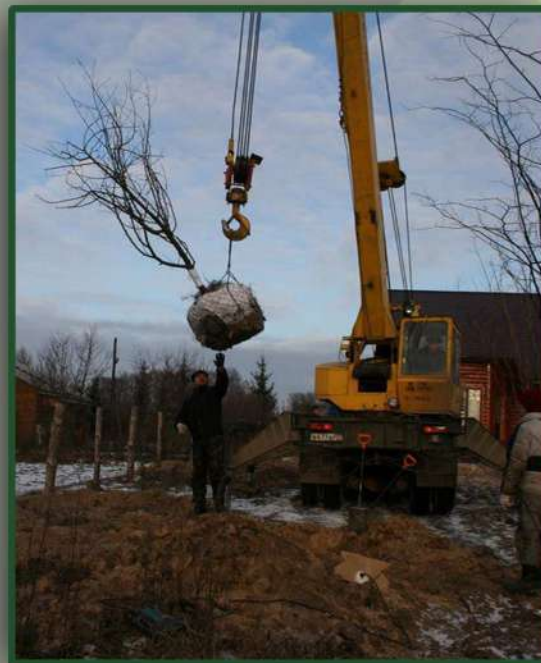
С участием механизации (землеройная техника + крановое и транспортное оборудование)
